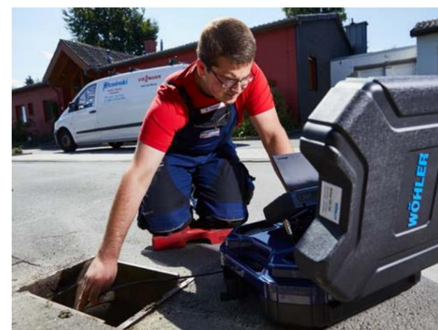
Надежный осмотр дренажа с помощью водонепроницаемой камеры
